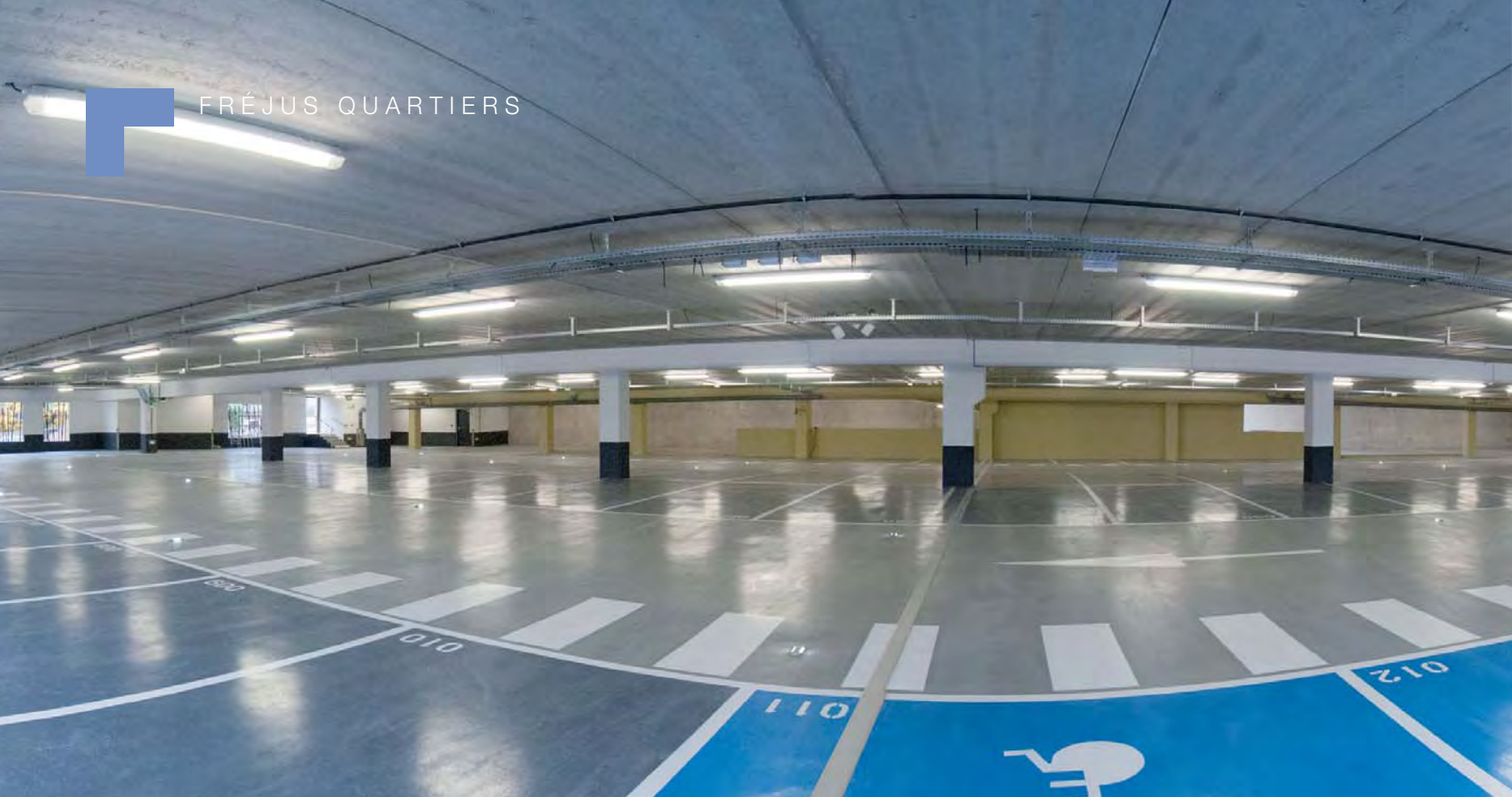
88 places très exactement - dont six emplacements réservés aux personnes à mobilité réduite - sont proposées à ce niveau intermédiaire du nouveau parking Aubenas, 102 au sous-sol et 104 sur l'étage supérieur. L'une des priorités a consisté à limiter les structures porteuses, au moyen d'alvéodalles longues portées, pour fluidifier la circulation et faciliter les manœuvres...
