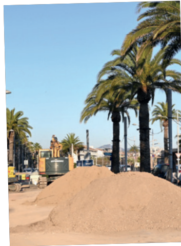
Le Maire, David Rachline, s'est rendu sur le boulevard d'Alger afin de faire un point d'étape sur l'avancement des travaux de la Promenade des Bains .
